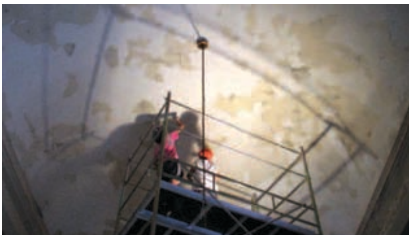
Teatro Masini: Operai al lavoro per stuccare e tinteggiare il soffitto del Ridotto.
