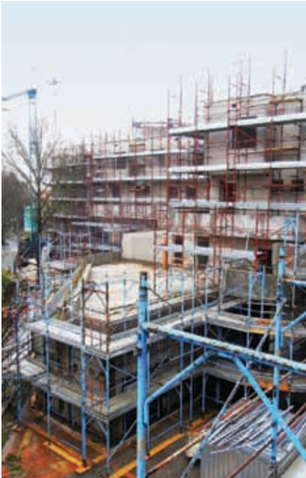
Foto 1. I fronti su via Fornarina avvolti dalle impalcature.
