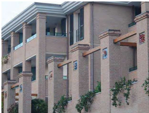
Veduta da via F.lli Rosselli del complesso in cui sono installate le opere
