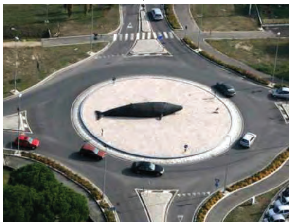
Veduta aerea dell'opera sulla rotonda
