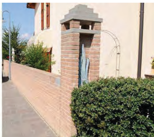
Particolare del pilastro a destra
